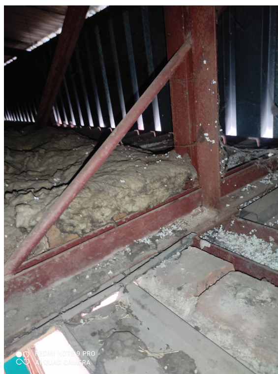
fot.12. Stalowa, kratownicowa konstrukcja dachu nad salą gimnastyczną
