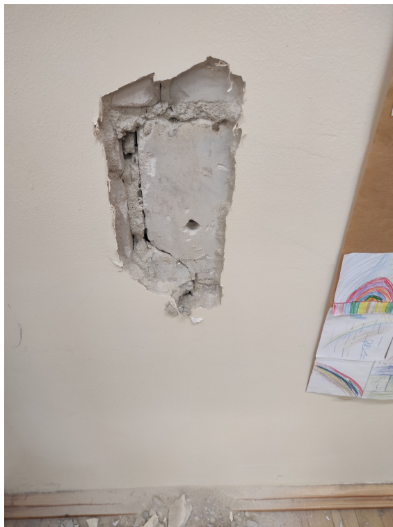
fot.3. Odkrywka ściany wewnętrznej podłużnej pod salą gimnastyczną
