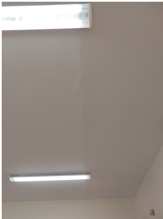
fot.9. Widoczny styk pomiędzy płytami kanałowymi
