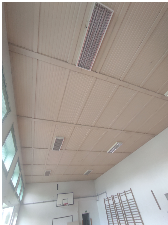
fot.13. Sufit nad salą gimnastyczną z blachy trapezowej
