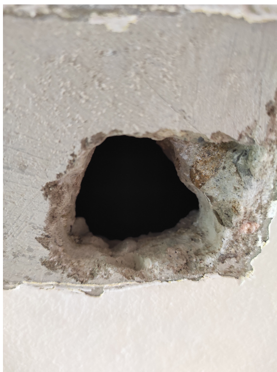
fot.8. Odkrywka stropu pod salą gimnastyczną. Widoczny kanał żelbetowej płyty kanałowej
