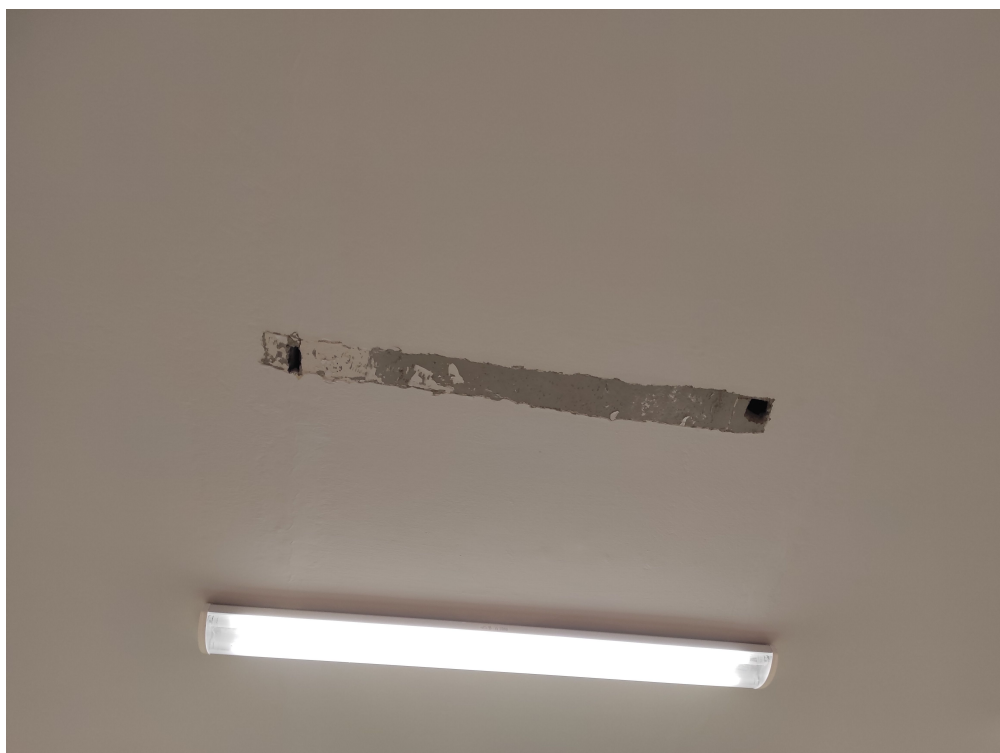
fot.6. Odkrywka stropu pod salą gimnastyczną
