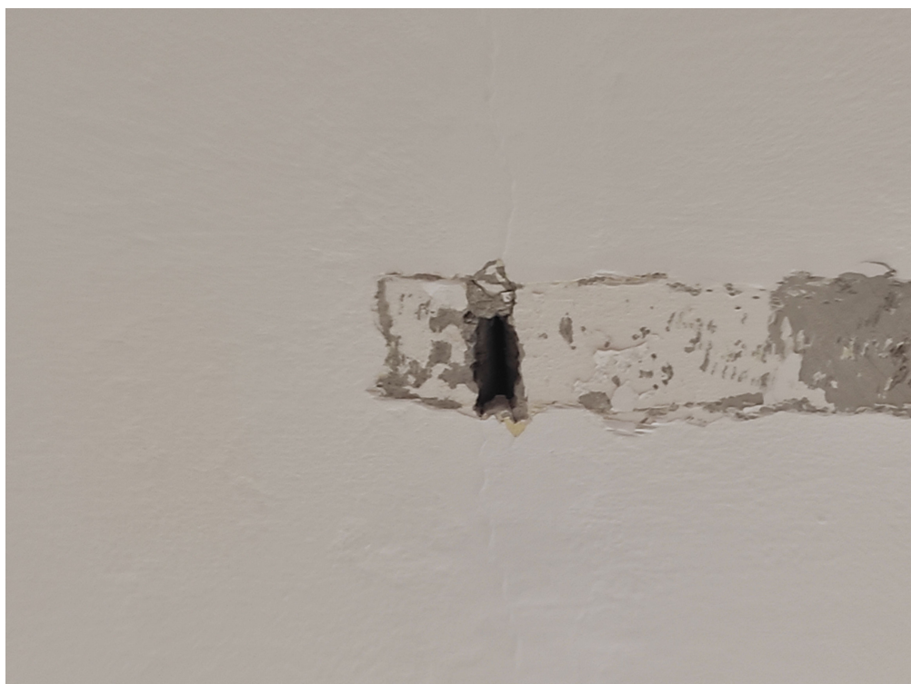
fot.10. Klawiszowanie płyt kanałowych
