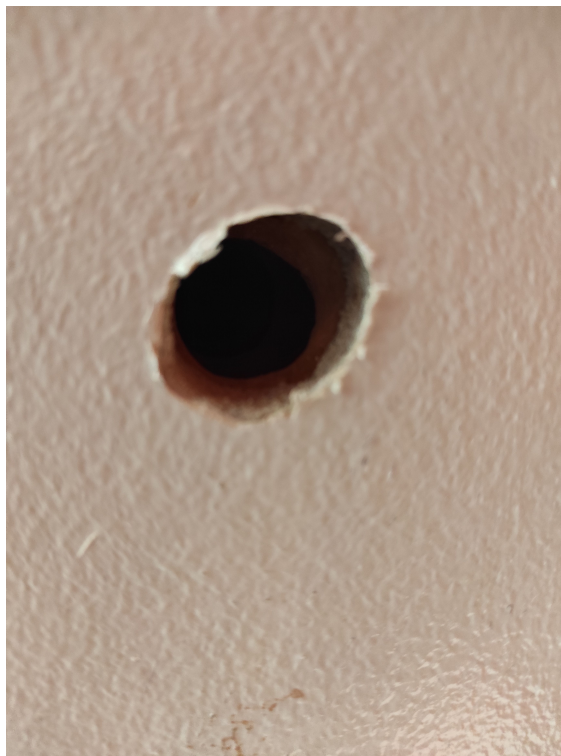
fot.5. Przewiert ściany zewnętrznej pod salą gimnastyczną. Mur z pustaków ceramicznych, szczelinowych
