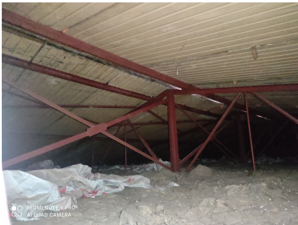
fot.11. Stalowa, kratownicowa konstrukcja dachu nad salą gimnastyczną
